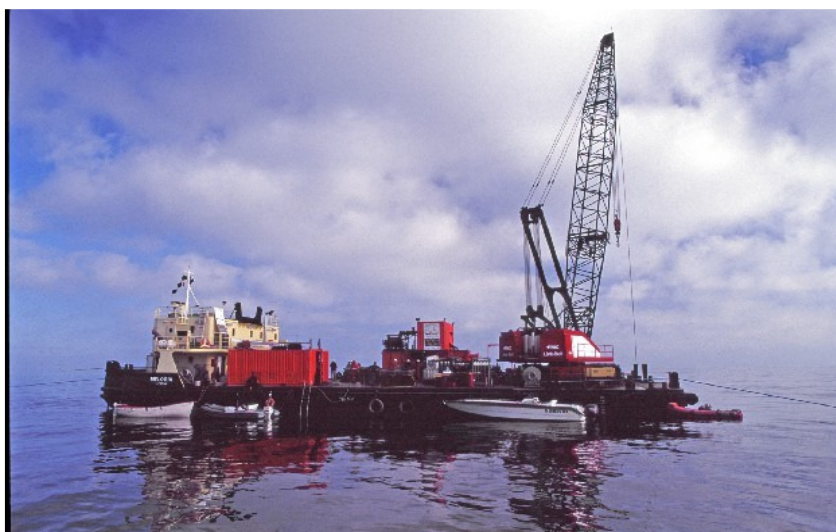
Figura 7 Il pontone Meloria della flotta Neri di Livorno, che ha ospitato il cantiere di scavo sul relitto del Polluce.
