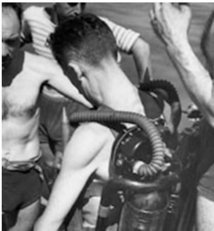
Fig. 8 - Il prototipo con corpo in bachelite dell'autorespiratore Cousteau-Gagnan durante le prime immersioni a Bandol. (da "La plongée autonome" di Claude Robinet e Luc Guillou, Marines édition, 1999)
