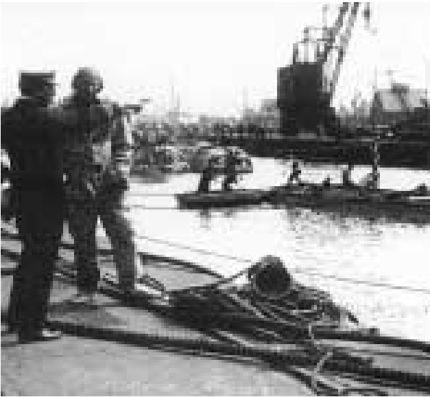
Massawa 1943. Sotto la direzione di Ellsberg, Frank Anderson ascolta le istruzioni. Si recupera un caccia adagiato su un fianco. Sono visibili i pontoni affondabili ideati da Ellsberg.
